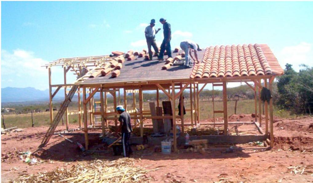
**Nota.** Proceso constructivo del bajareque mejorado: etapas de cimentación y anclaje de estructura vertical de madera, estructura de techumbre, colocación de impermeabilizante y teja de barro artesanal en cubierta, rodapié de ladrillo y entramado de cañamaíz en muros, tejido de ladrillo sobre cama de arena en pisos, embarro y encalado de muros; obra construida por el autor en 2007.
